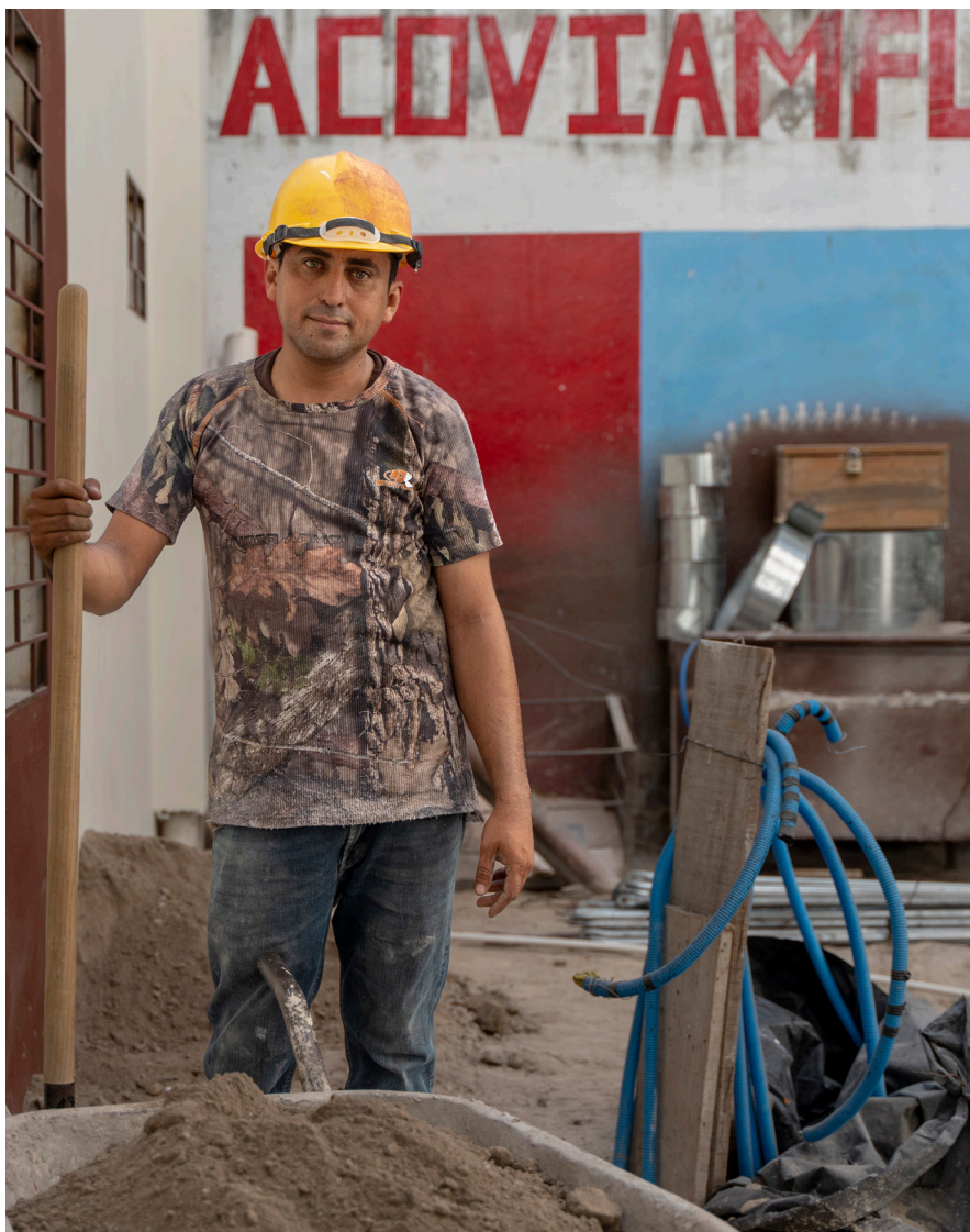
Lavori di riqualificazione nel Centro storico di San Salvador 2025 - febbraio 2025
