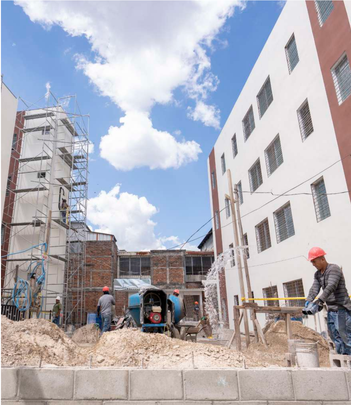
Rehabilitación de 64 viviendas de vivienda social en el centro histórico de San Salvador - Marzo 2025
