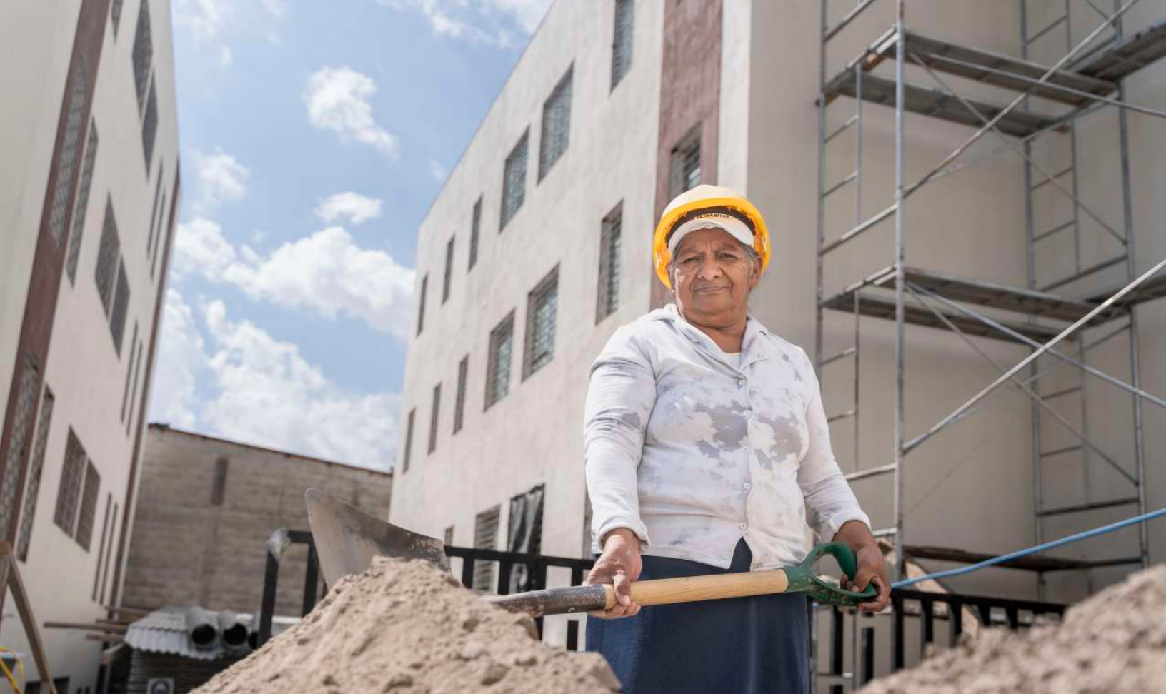
Trabajos de construcción de viviendas social pública, realizados con la participación de cooperativas en el centro de San Salvador - Marzo de 2025.
