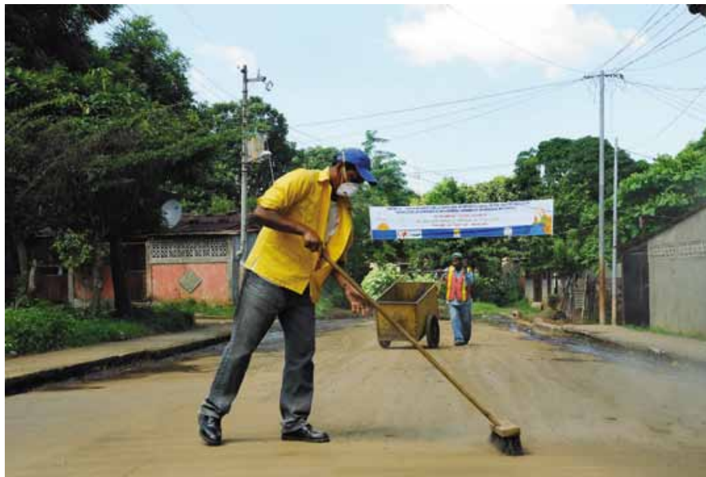
TAMBIÉN SE TRABAJA en la construcción de 70 sistemas sanitarios ecológicos.
